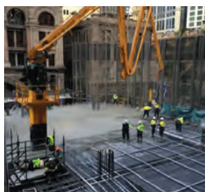
Envisia® concrete pour
